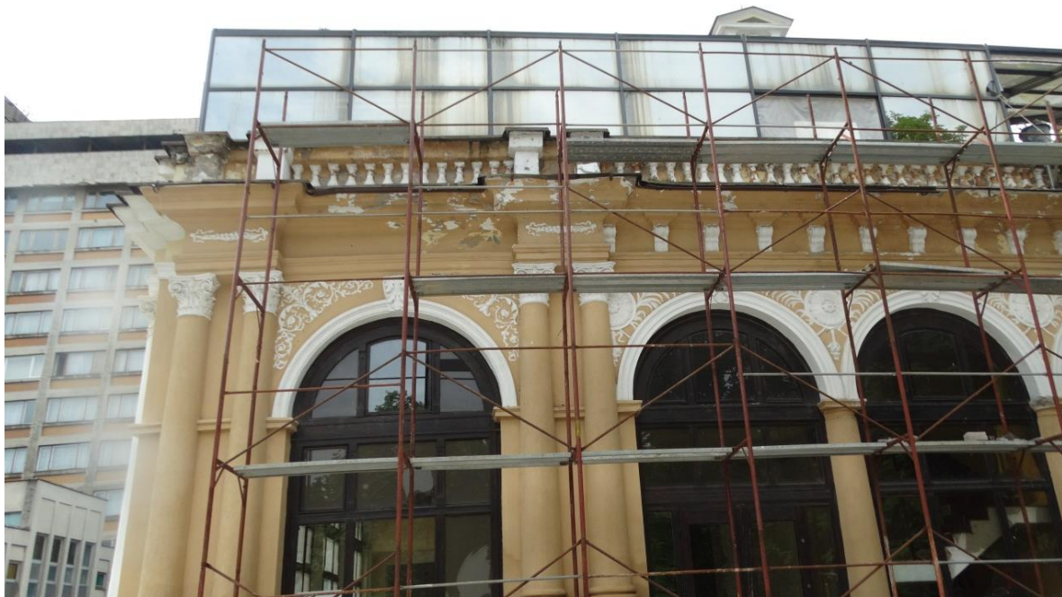
Fațada de nord-vest, stadiu actual
