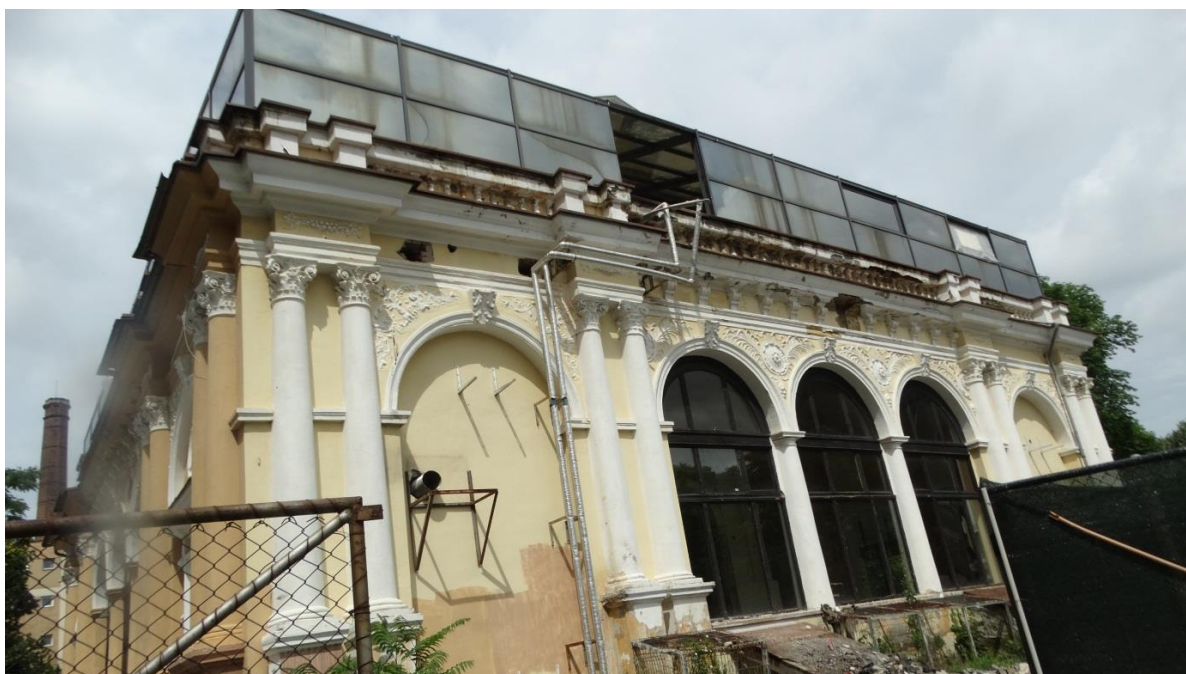
Fațada de est, stadiu actual
