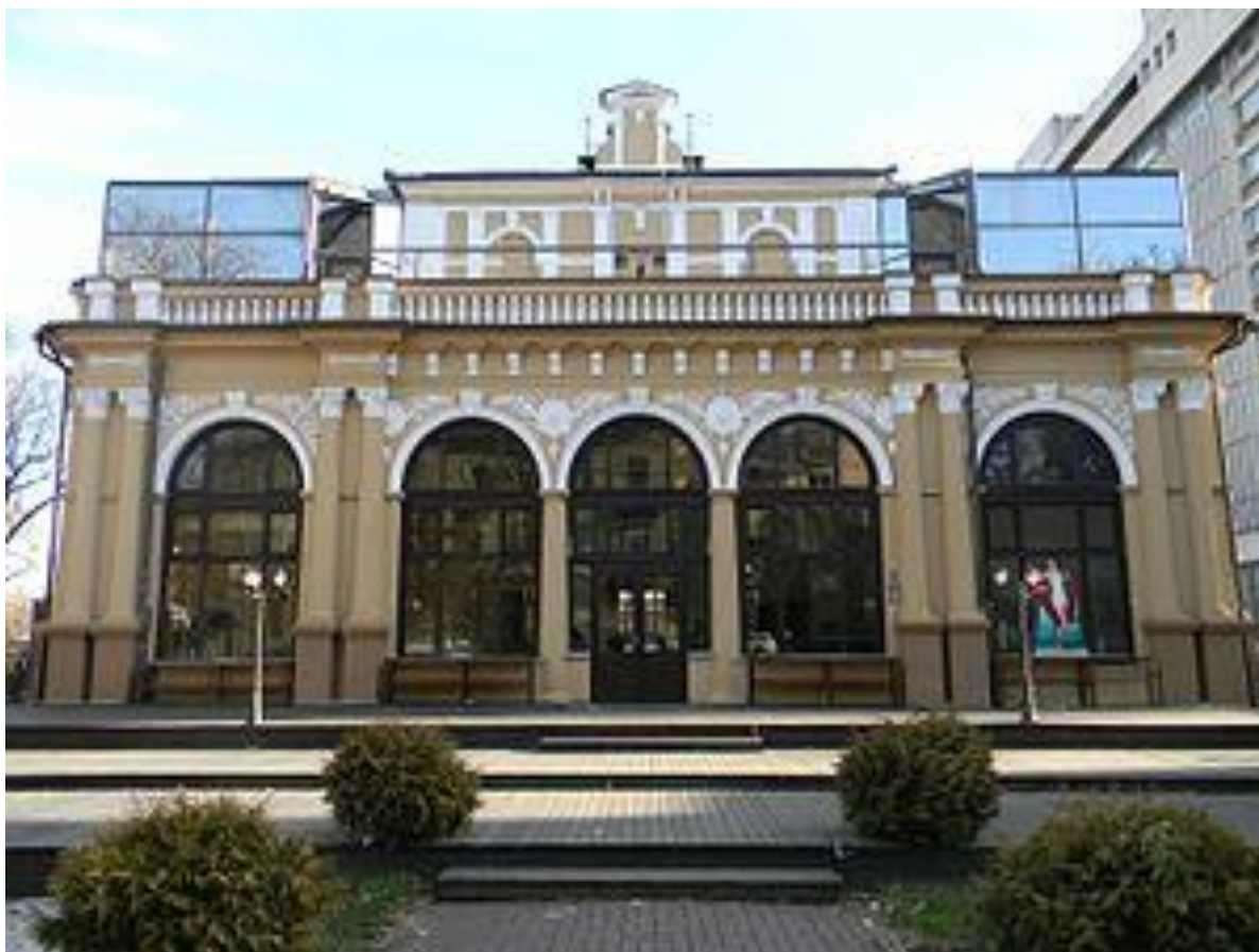
Fațada de vest, stadiu actual
