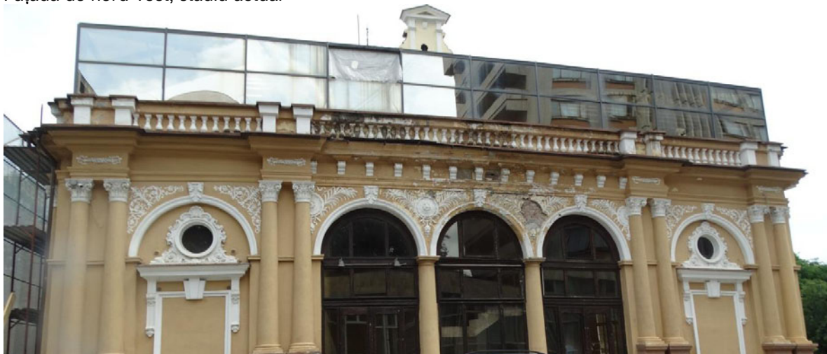
Fațada de sud, stadiu actual
