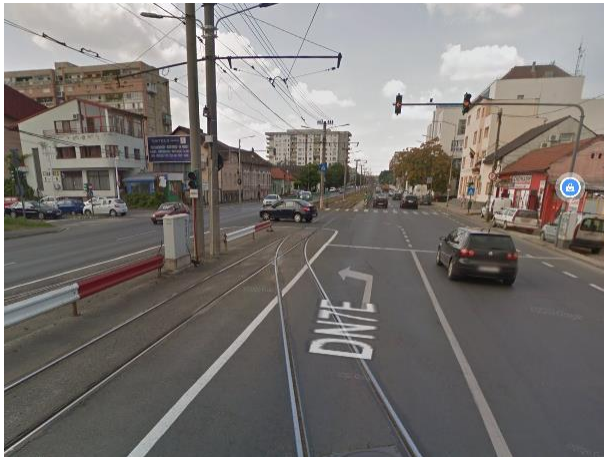
Figura 3.66. Calea Iuliu Maniu - încadrare linie tramvai dinspre N. Titulescu / Micalaca cu traversare oblică peste zona de stocaj la intersecție semaforizată, zonă ce poate fi blocată de vehicule rămase în așteptare la semafor.
