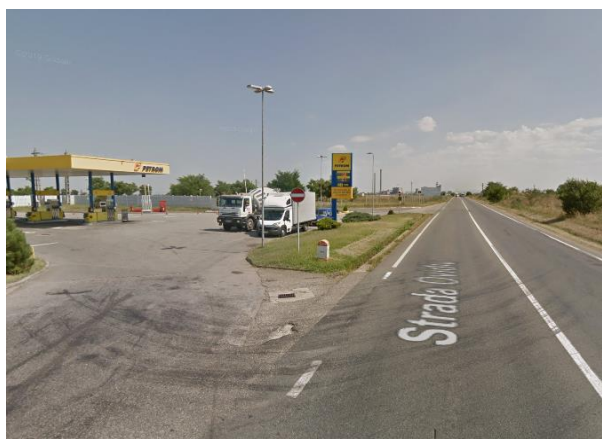
Figura 3.24. Acces stație alimentare carburant insuficient amenajat, vizibile urme de viraj dreapta peste linia continuă. Sursa: Google Maps.
