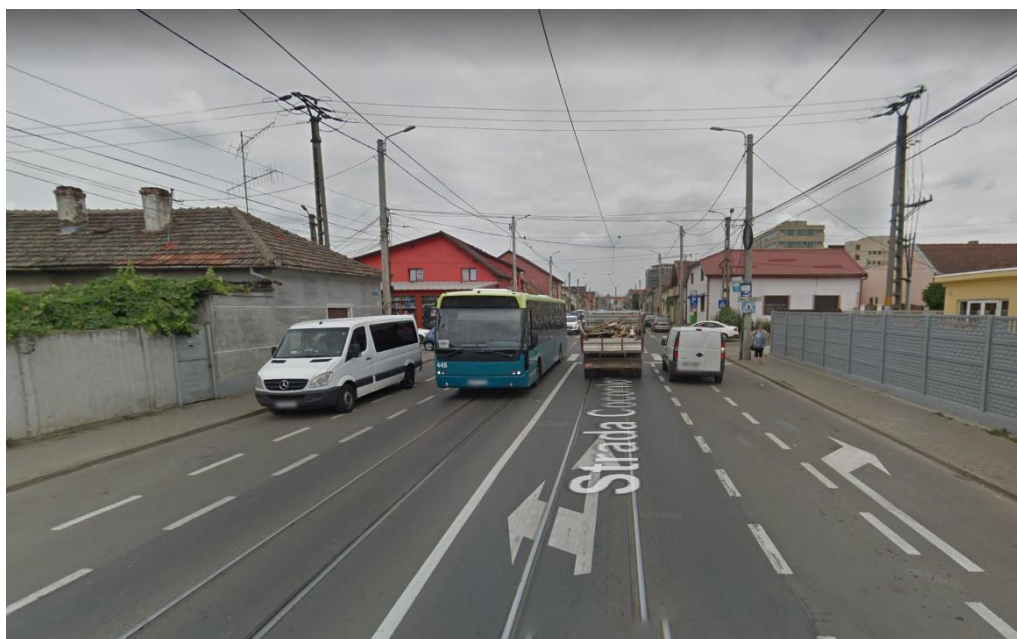
Figura 3.50. Str. Cocorilor - bandă de circulație suprapusă peste linia de tramvai (câte 3,5 m/sens), piste de biciclete, benzi de parcare longitudinale, trotuare blocate de stâlpii de iluminat. Sursa: Google Maps.
