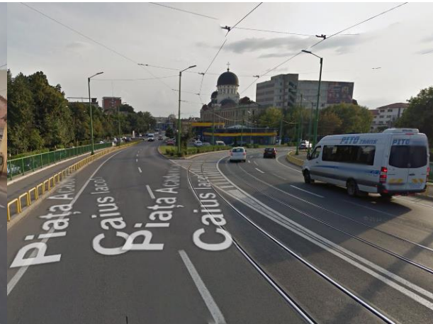
Figura 3.67. Încadrare oblică cu semnalizare insuficientă a liniei de tramvai dinspre Gară spre Cartier Grădiște pe rampa pasajului peste calea ferată de pe Str. Petru Rareș.
