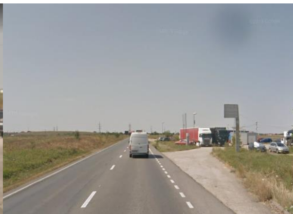
Figura 3.22. Parcare laterală cu intrări/ ieșiri neamenajate și marcaj axial pe CNA cu linie întreruptă (posibile viraje la stânga în și din CNA). Sursa: Google Maps.
