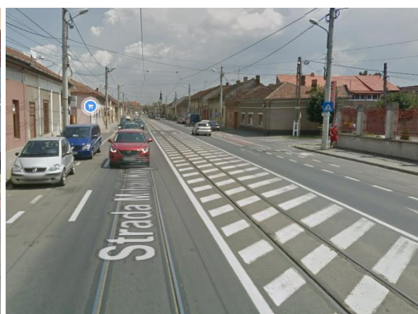
Figura 3.78. Piste pentru biciclete și benzi de parcare la bordură pe Str. M. Kogălniceanu prin desființarea unei benzi și obligarea vehiculelor să circule pe linia de tramvai. Sursa: Google Maps.
