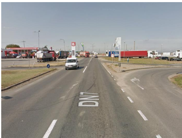
Figura 3.15. Bretele de intrare/ieșire în stațiile de carburanți aproape de calea inelară, fără separator axial/longitudinal pe brațul centurii. Sursa: Google Maps.
