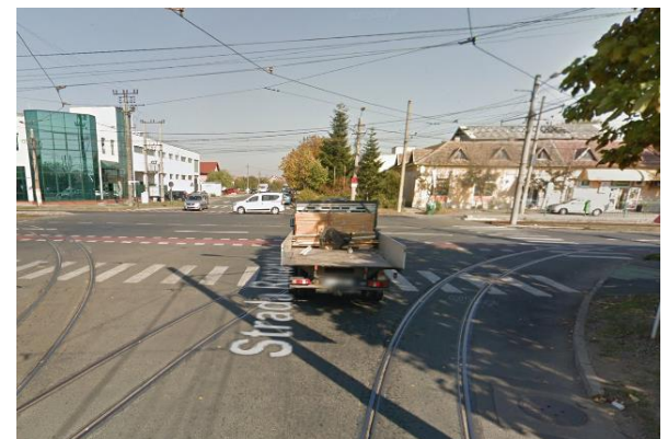
Figura 3.65. Intersecție Calea Radnei cu Str. Renașterii, cu linie în carosabil și ramificație care ocupă tot spațiul intersecției/ benzile de circulație.
