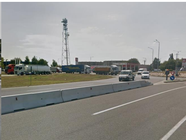
Figura 3.17. Separator/parapet median pe brațul nordic al DN 79 (local cu 2 benzi pe sens) pentru interzicerea manevrelor la stânga. Sursa: Google Maps.
