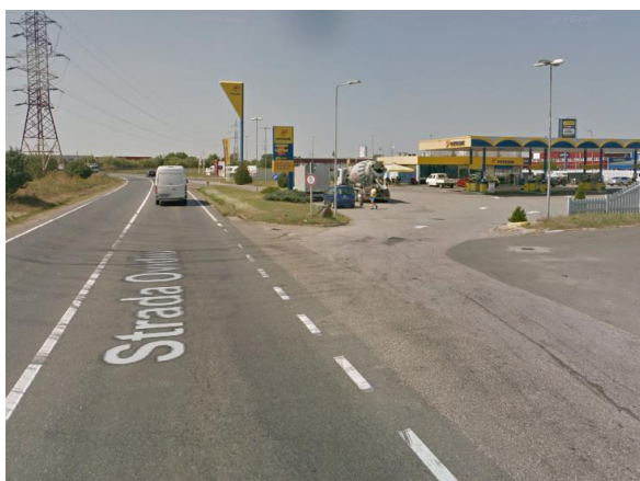
Figura 3.23. Acces stație alimentare carburant insuficient amenajat, vizibile urme de viraj stânga peste linia continuă. Sursa: Google Maps.
