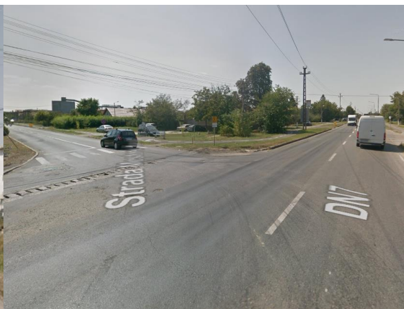
Figura 3.26. Intersecție CNA cu Str. Meșterul Manole neamenajată, viraje la stânga necontrolate, lipsă separatori de circulație. Sursa: Google Maps.
