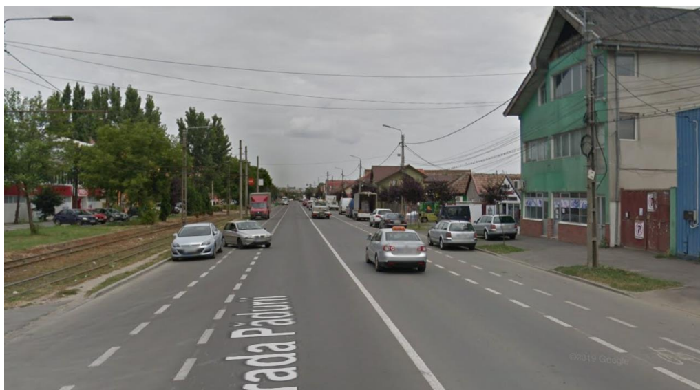
Figura 3.51. Str. Pădurii - bandă laterală de circulație partajată/ împărțită în bandă de parcare și pistă de biciclete, parcări paralele pe trotuar, manevre de ieșire din parcare cu traversarea pistei de biciclete. Sursa: Google Maps.
