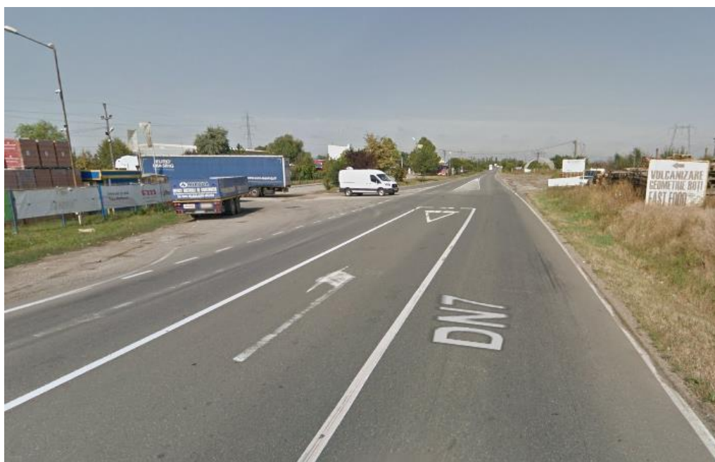
Figura 3.11. Acces lateral stânga, intersecție la nivel cu viraj stânga fără separatori (insule denivelate), cu risc sporit pentru siguranța circulației în special noaptea (lipsă iluminat public). Sursa: Google Maps.
