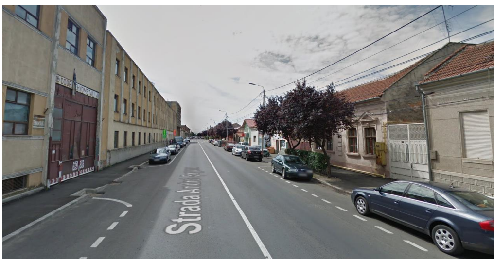
Figura 3.49. Str. Andrei Șaguna, benzi laterale longitudinale pentru parcare, pe toată lungimea străzii. Sursa: Google Maps.
