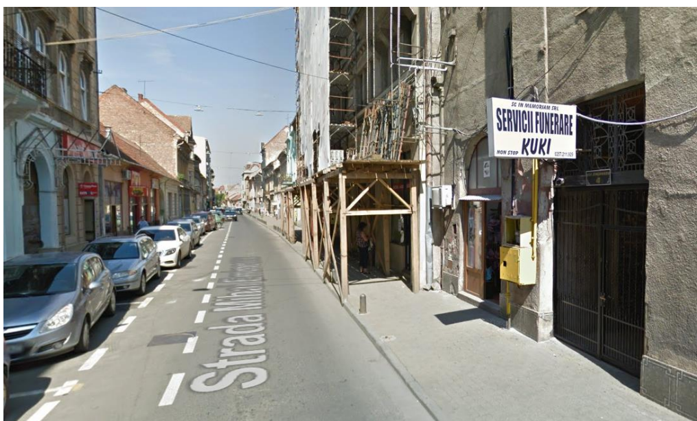
Figura 3.47. Str. Mihai Eminescu, zona de mijloc (pistă de biciclete ocupată parțial de vehicule parcate, trotuar insuficient pe partea stânga). Sursa: Google Maps.
